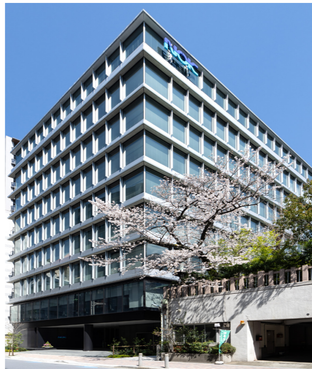
外壁を三面ガラス張りにし、自然光を効果的に取り込める造りに
