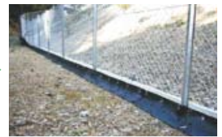
利用例：小動物侵入防止壁 ゴムチップをウレタン樹脂と混ぜて型に入れマット状に成型し、防止壁の材料として利用される
