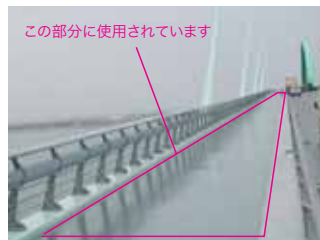
ゴムブロック施工例（北九州新空港連絡橋）
